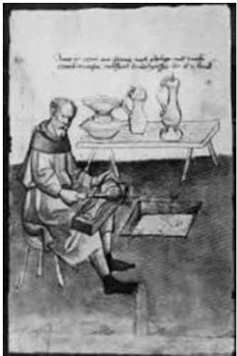
Foto 1. Maestro Peltraio Wolhard, anno 1428. La più antica raffigurazione conosciuta di un laboratorio di peltraio. Il Maestro Wolhard versa stagno fuso attorno all'anima in legno di un boccale.
